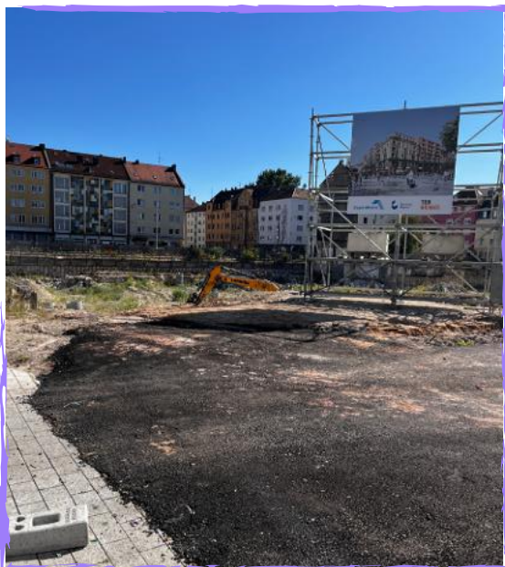
Abbildung 19: Baugrube („Lago die Aufseß“) am Aufseßplatz (eigenes Foto: Protokoll Stadtteilbegehung siehe Anhang 4)
